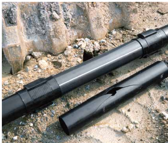
Belegte Rohrtrassen lassen sich schnell und wirtschaftlich reparieren.
