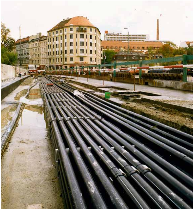
gabocom Halbrohre werden hier in einer Rohrtrasse verlegt.
